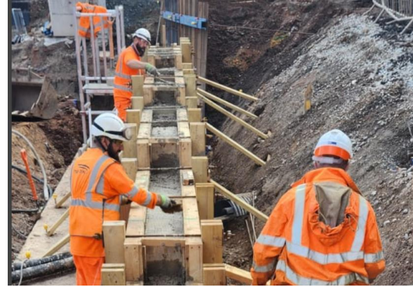
UTILITIES RETAINING WALL 1st SECTION WALL POUR
